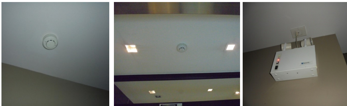
ภาพที่ 4-18 เครื่องตรวจจับควันบริเวณทางเดิน ไฟส่องสว่าง และไฟฉุกเฉิน
