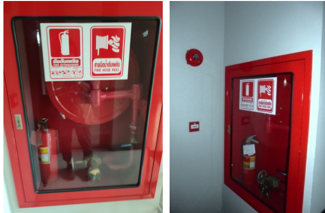
ภาพที่ 4-17 ตู้เก็บสายฉีดน้ำดับเพลิงพร้อมอุปกรณ์ติดตั้งไว้ใกล้กับ กริ่งสัญญาณดับเพลิงและ Manual Station
